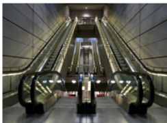
工程自动化/扶梯、电梯行业应用
